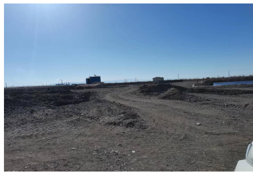
照片 3-2 项目区地形地貌 2
